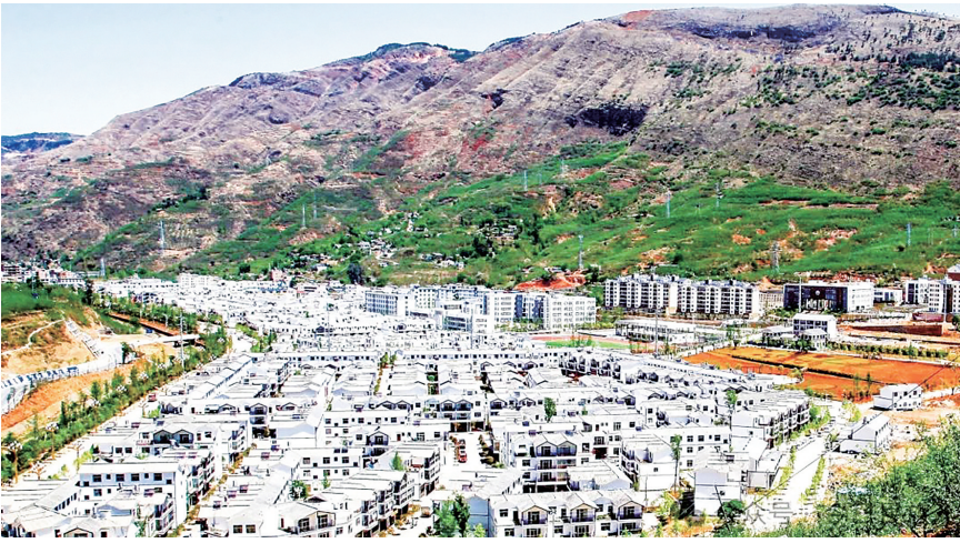
鲁甸县龙头山镇恢复重建后全景
